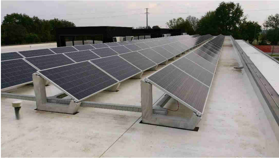
Fig. 8. 30kW PV field
